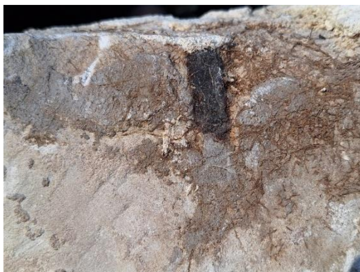
Mortier de ciment gris beige largement débordant au revers
