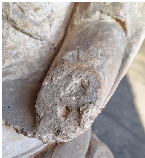
Cavités percées dans la pierre pour l'introduction d'un goujon et clavette (ou une agrafe) réassemblant anciennement la main et le poignet droit de la Vierge à l'ensemble
