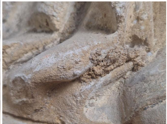
Projections de mortier de chaux obstruant certains reliefs
